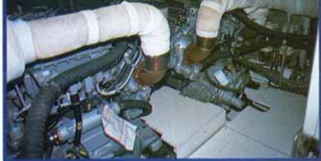
Motor Muito bem-ventilado e espaço suficiente para a manutenção de rotina nos dois MTU de 1.150 hp cada
