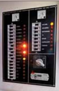
A fiação é estanhada, mas não codificada, como seria o ideal. A chave da bateria fica em local acessível e protegido da água. A instalação foi dimensionada para suprir o condicionador de ar, o gerador e a rede de 110 V — todos, porém, opcionais.
