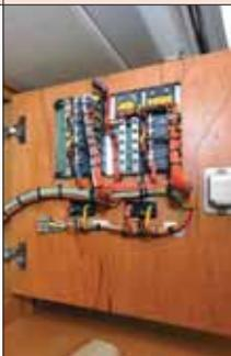
Todos os fios são estanhados, bem fixados e bem dimensionados. O quadro de distribuição é bem montado e a chave de bateria fica abrigada da água, na cabine de popa. Todas as luzes a bordo são de leds, que não esquentam e gastam menos energia.
